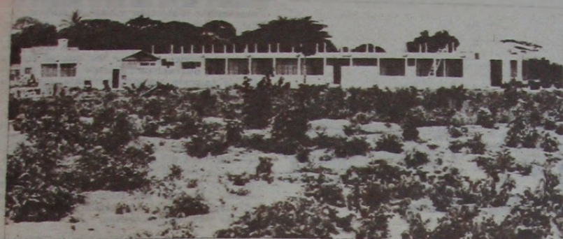
Nuevo hospital rural en construcción, en Macomia, que reemplazará al hospital de campaña que existió en aquella zona liberada por el FRELIMO durante la guerra.
