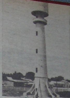
A punto de terminarse la estación de tratamientos de agua de Benguela.
