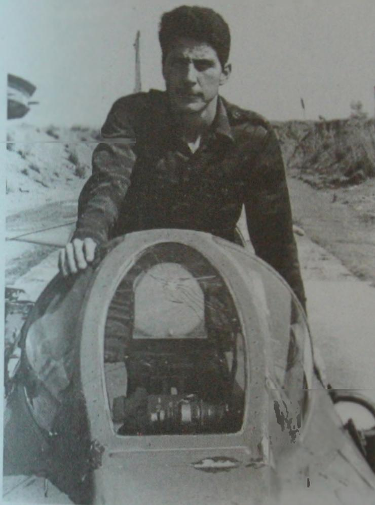
Fig. 4. Impacto de proyectil en el cristal delantero del avión tripulado por el primer teniente Pedro González Pool. El cristal resistió sin romperse. Decididamente estaba *salao*.
